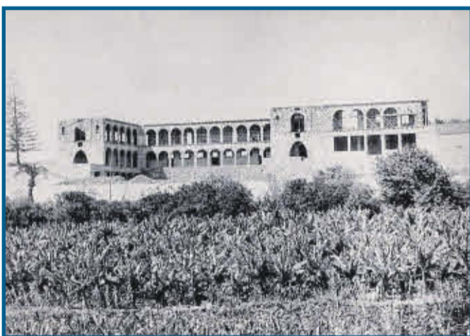
Estructura del edificio docente en construcción. | ARCHIVO DE LA COGREGACIÓN SALESIANA
