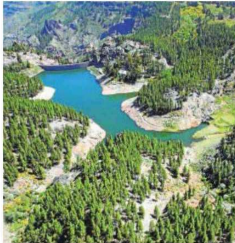
Vista de la presa de La Cumbre o de Los Hornos. C7
